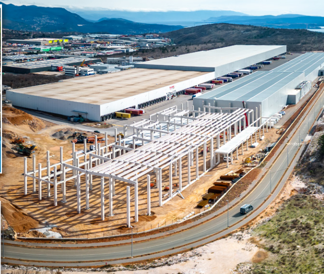
Izgrađena prometnica u sklopu projekta "GOSPODARSKO SREDIŠTE HRVATSKOG PRIMORJA"
