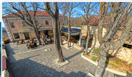
Uređenje dvorišta ispred Doma kulture Hreljin
