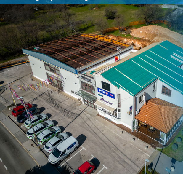
Rekonstrukcija Doma kulture Kukuljanovo i izgradnja natkrivenog bočališta
